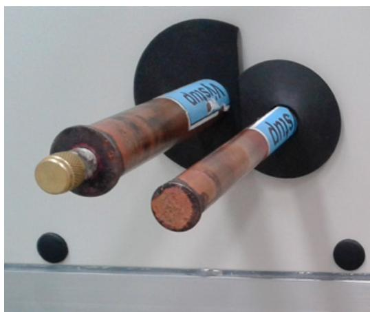
příklad provedení připojovacích hrdel
