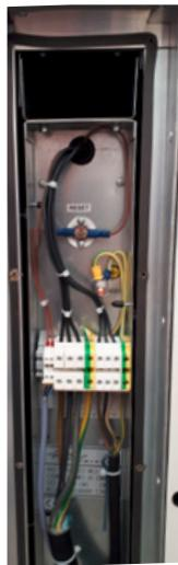
přístup k připojovací svorkovnici ohřívače –
