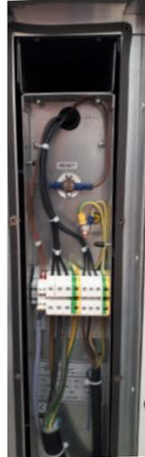
Zugang zu der Anschlussklemme des Erhitzers –
