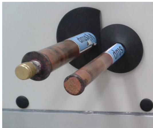
Beispiel der Ausführung von Anschlussstutzen eines Kreislaufs des Direktverdampfers
