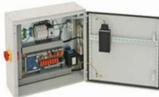
Steuerungseinheit Digireg® IP65 – offenes Gehäuse
